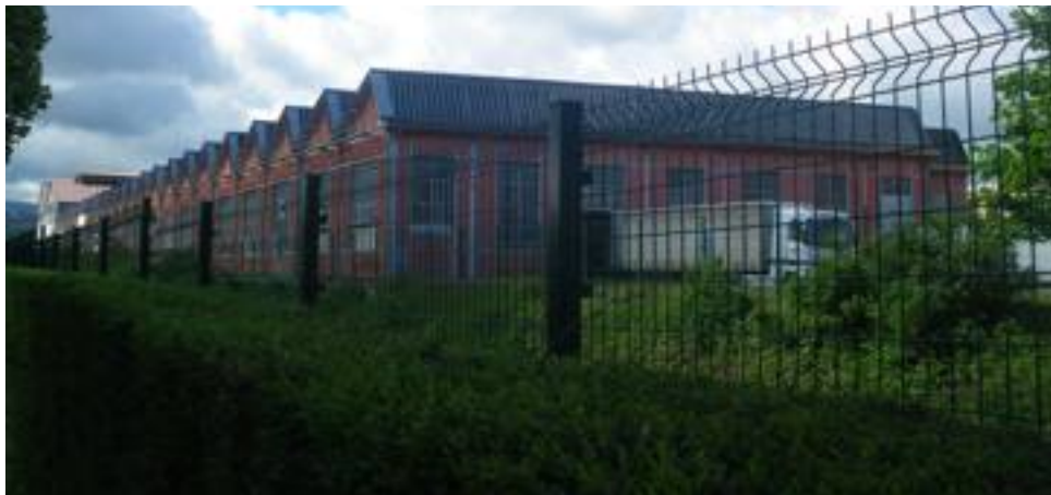
■ Sur l'emplacement des « usines Barrouin », se dressent encore quelques bâtiments qui rappellent le passé industriel du quartier. Photo Pascale Bigay
